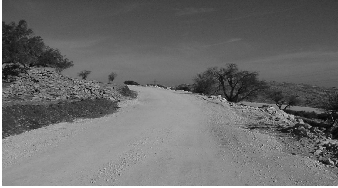
شكل 2: طريق ثانوي دون أكتاف مناسبة
