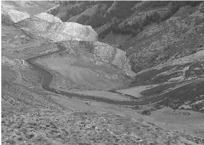
شكل 3: طريق ذو منحنيات أفقية حادة وامتتالية
