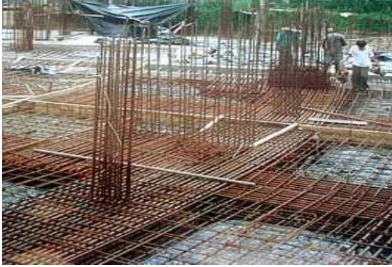
شكل (3.5) : كثرة حديد التسليح في الجسور والبلاطات، وازدحامها عند نقط التقائها بالأعمدة (المؤلف)
