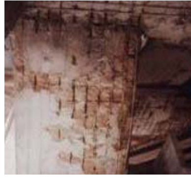
شكل (26.7): اهتراء و تفتت الخرسانة وصدأ حديد التسليح (المؤلف)
