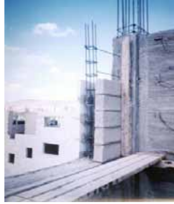
شكل (8.5): تسليح فتحات النوافذ والأبواب (المؤلف)
