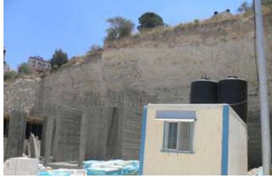
شكل(3.7): ضرورة تسوية الأرض الصخرية عند مستوى التأسيس (المؤلف)
