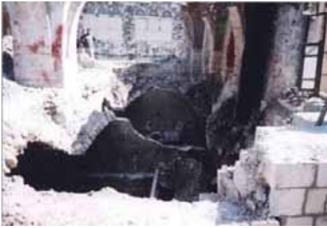
انهيار سقف من العقود المصلبة
