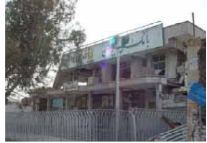
شكل(24.7): تساقط قطع الجدران الخارجية بسبب تأثير الحركات الاهتزازية (تقاريرالمعهد EERI)
