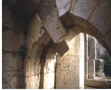
أ. تشوهات في أقواس و عقود قلعة النمرود نتيجة لزلزال 1759
