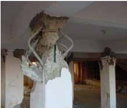
شكل (10.5): أضرار وانهيارات بسبب حديد التسليح (تقارير المعهد EERI)
