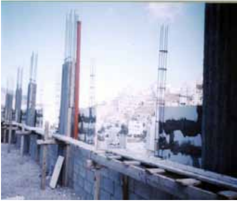
شكل (8.5): تسليح فتحات النوافذ والأبواب (المؤلف)
