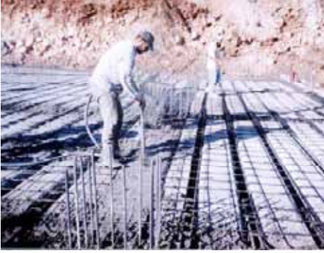
شكل (5.4): دمك الخرسانة ورَّجَّها أثناء عملية الصب
