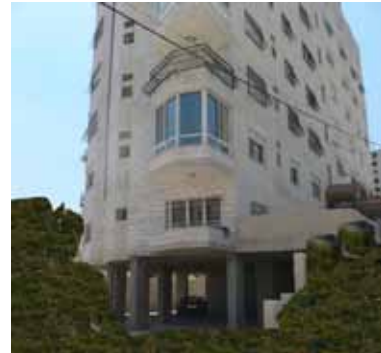
شكل(16.7) : أنماط المباني الدارجة محلياً و ظاهرة الطابق الرخو (المؤلف)
