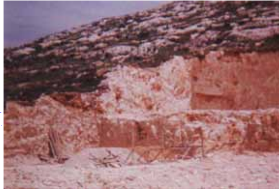
شكل(4.7): تسوية الأرض الصخرية المنحدرة على شكل درج أو قصبات (المؤلف)
