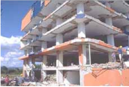
شكل(24.7): تساقط قطع الجدران الخارجية بسبب تأثير الحركات الاهتزازية (تقاريرالمعهد EERI)
