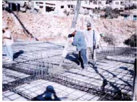
شكل (5.4): دمك الخرسانة ورَّجَّها أثناء عملية الصب
