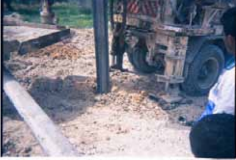
شكل (5.6) : تنفيذ الأوتاد الخرسانية المسلحة في المنطقة السفلية للانحدار، (الدبيك جلال، وجرداته عصام، والجوهري عبد الحكيم، 1998)
