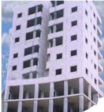
شكل(16.7) : أنماط المباني الدارجة محلياً و ظاهرة الطابق الرخو (المؤلف)
