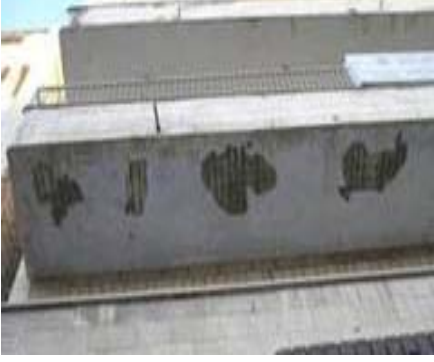
شكل (26.7): اهتراء و تفتت الخرسانة وصدأ حديد التسليح (المؤلف)
