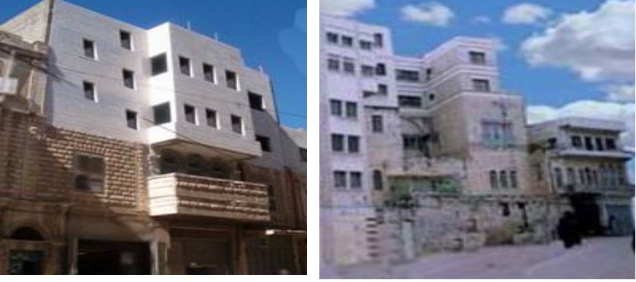
شكل(25.7): البناء فوق مباني قائمة قديمة (المؤلف)
