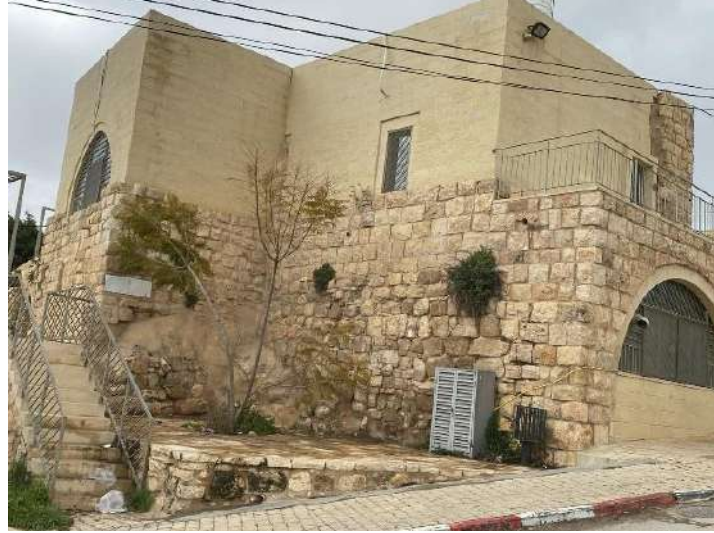
شكل (2) يوضح الشكل الخارجي للمبنى، المصدر: تصوير الباحث
