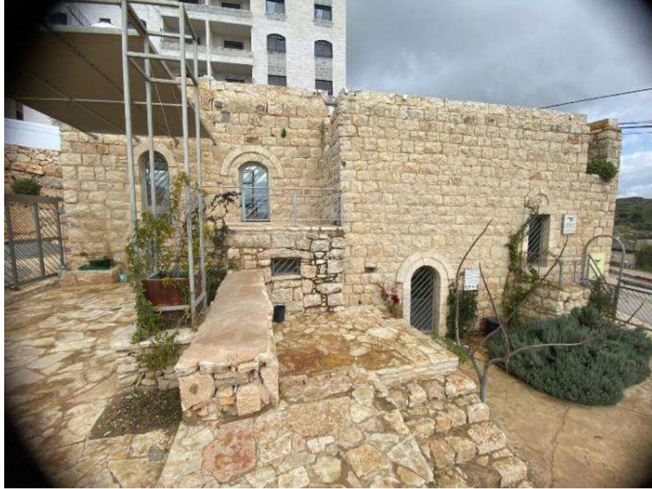
شكل (3) يوضح الشكل الخارجي للمبنى، المصدر: تصوير الباحث
